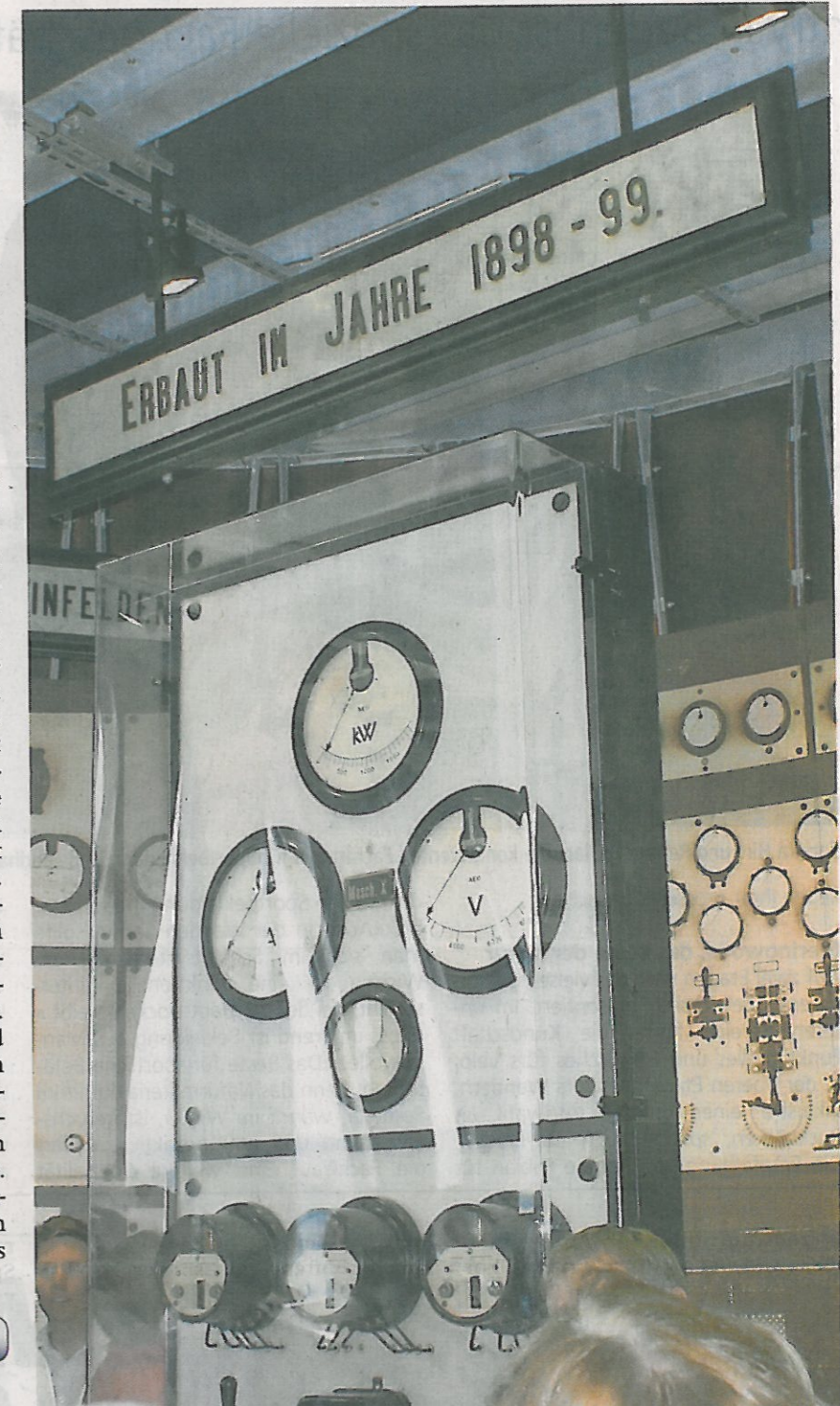
Vor dem Abriss gerettet: Alte Kraftwerk-Schaltanlage im Pavillon. ACH
